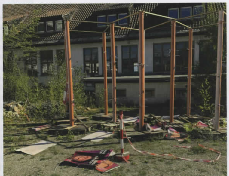
Abbildung 6: Zustand nach Beendigung des Freiversuches.
